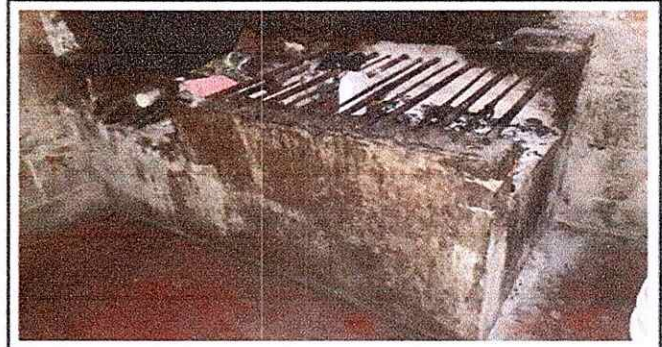
Foto 4: la cocina no cuenta con una planca formal con chimenea para la preparacion de los alimentos de los niños.
